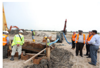
Suzila (4 th from right) observing the installation of sewerage system. Suzila (ke-4 dari kanan) meninjau pemasangan sistem pembentungan
